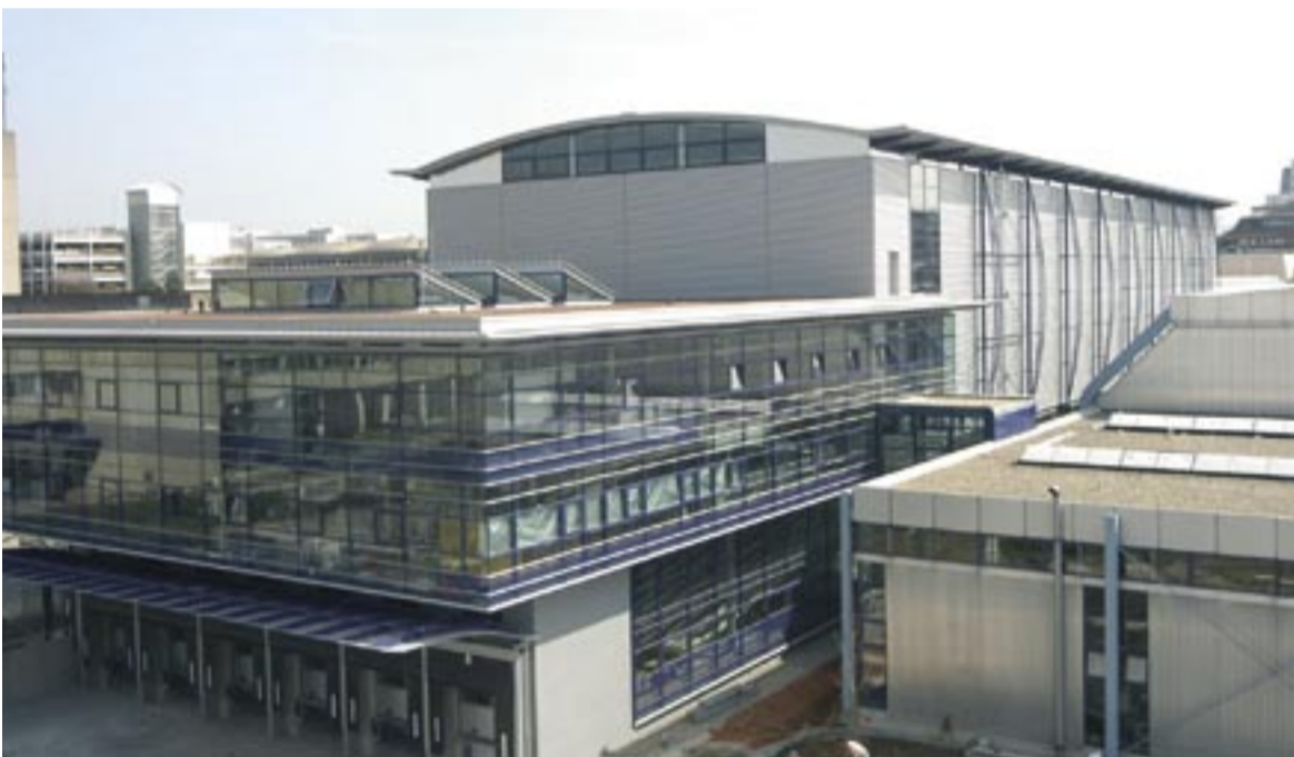
Das neue HERMA Logistik-Zentrum entstand in 17 monatiger Bauzeit und mit Investitionen in Höhe von rund 15 Mio. Euro.
