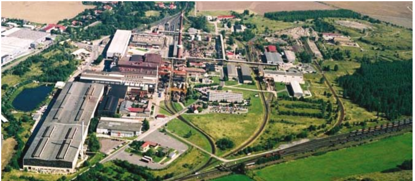
Werksgelände der Isenburger Grobblech GmbH
