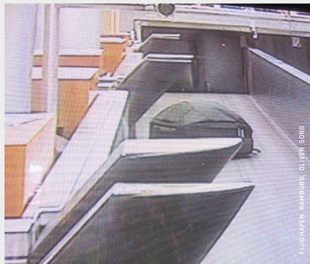
Mit der PSI-Software werden die Schnittstellen zur Steuerungsebene der Anlage geführt. Die KI-Anwendung ermöglicht es, die Kamerabilder in Echtzeit direkt zu verarbeiten.
