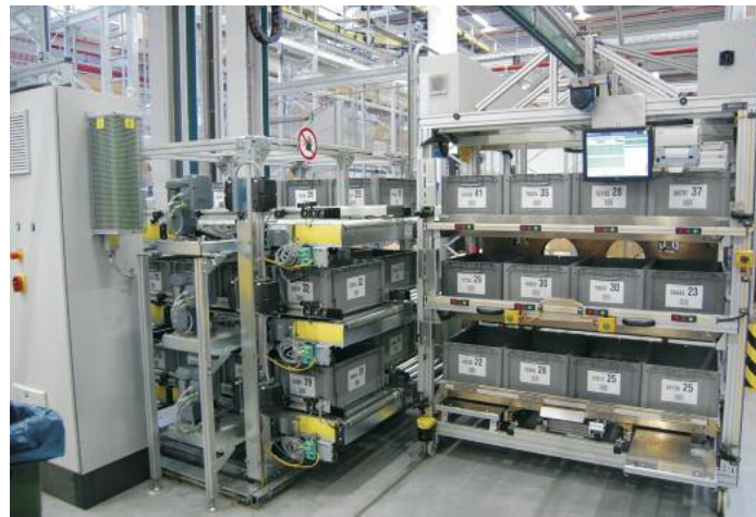
Kommissionierstation in der Vorzone des automatischen Kleinteilelagers im Kärcher-Ersatzteillogistikzentrum
